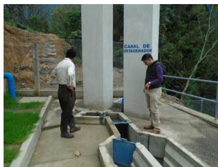
Supervisión de Planta de tratamiento de aguas de Aldea Santa Rita
