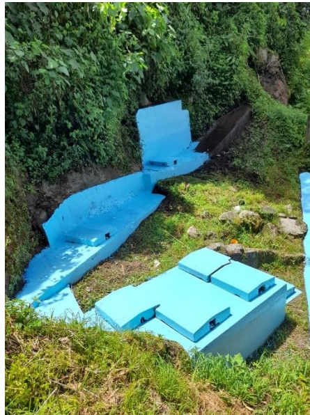
Mantenimiento en fuentes de agua Siete Tambores
