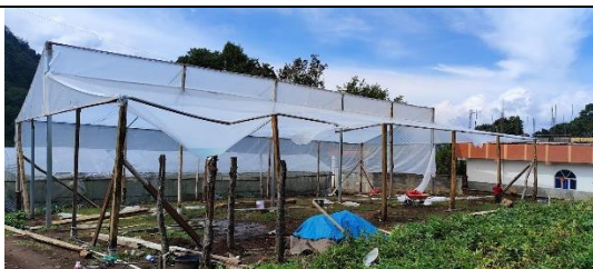
Figura 5: Asesoramiento para la construcción de invernadero en Santa Rita.
